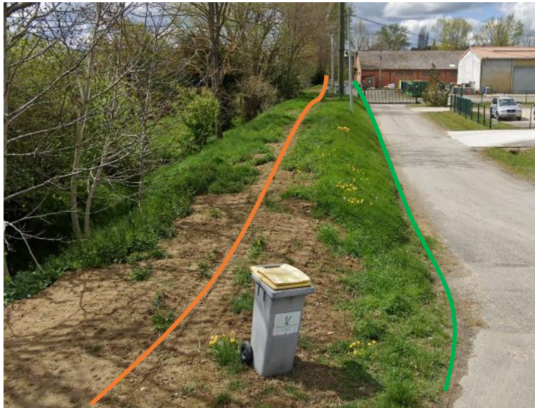
Figure 6 : Traces de la tranchée rebouchée dans le corps de l'ouvrage pour alimenter l'antenne relai
