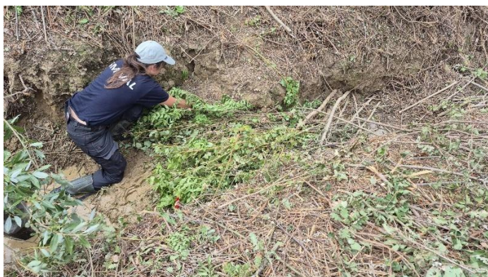
Réalisation des ouvrages filtrants
