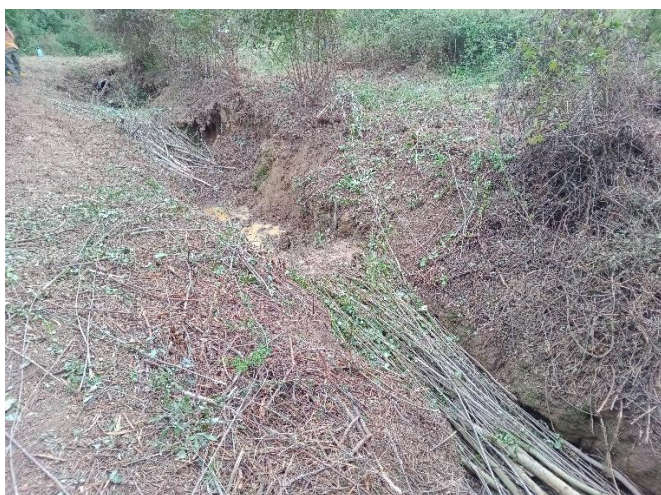
Ouvrages filtrants réalisés en septembre 2025 (à gauche) et en décembre 2025 (à droite)
