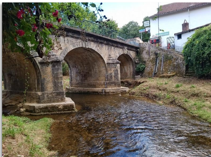
Suivi d'ouvrage (pont de Pailhès)
