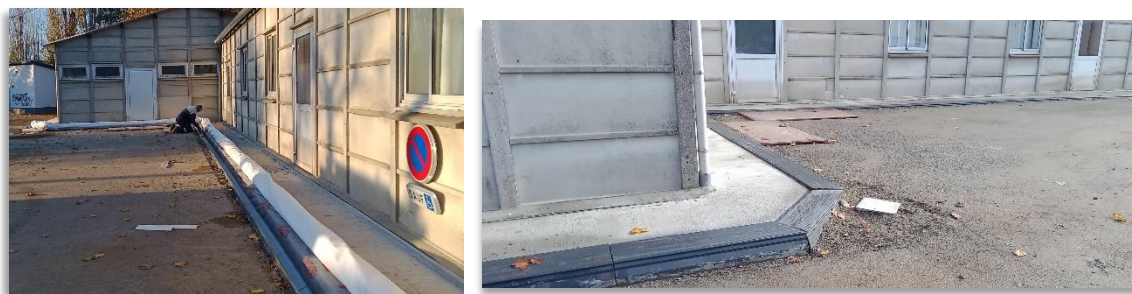
À g. : Mise en place du système FloodFrame sur la salle des fêtes de Lézat-sur-Lèze — à dr. : Dispositif FloodFrame posé définitivement autour de la salle des fêtes de Lézat-sur-Lèze
