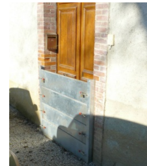
Simple à mettre en oeuvre, les batardeaux forment une barrière étanche et amovible efficace pour se prémunir des inondations rapides.
