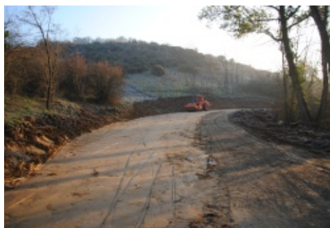
Pendant les travaux
