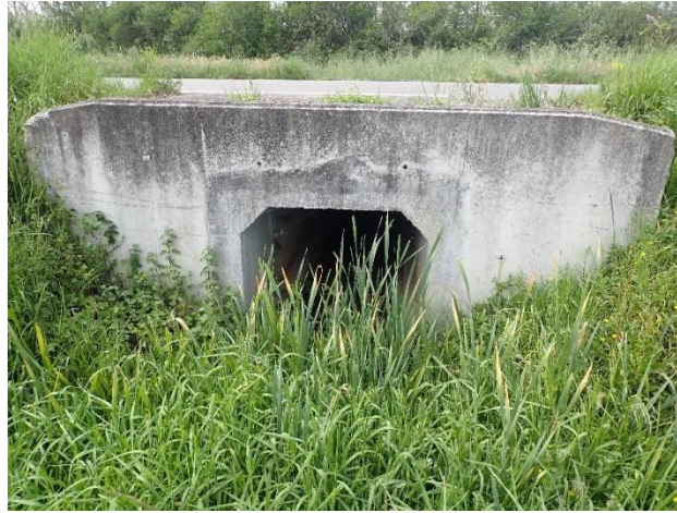
Figure 25: Vue du réseau d'assainissement traversant la RD919
