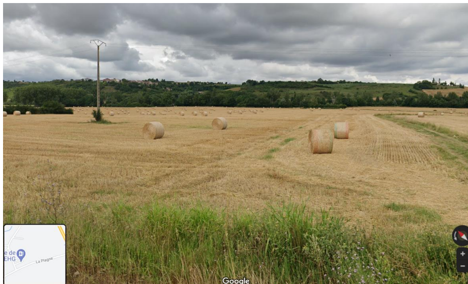
Figure 24: Vue de la ligne HT au droit du raccord barrage/TN (source : Google StreetView)
