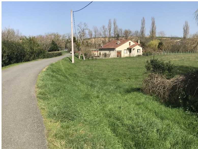
Figure 18: Vue du remblai de l'ancienne voie ferrée (chemin du Tortillard) sur laquelle la digue se referme au nord
